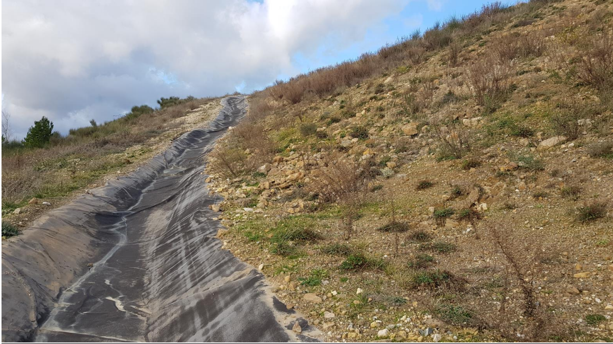
Zone 7 inférieure : Traces de ravinement sur le talus amont du fossé
