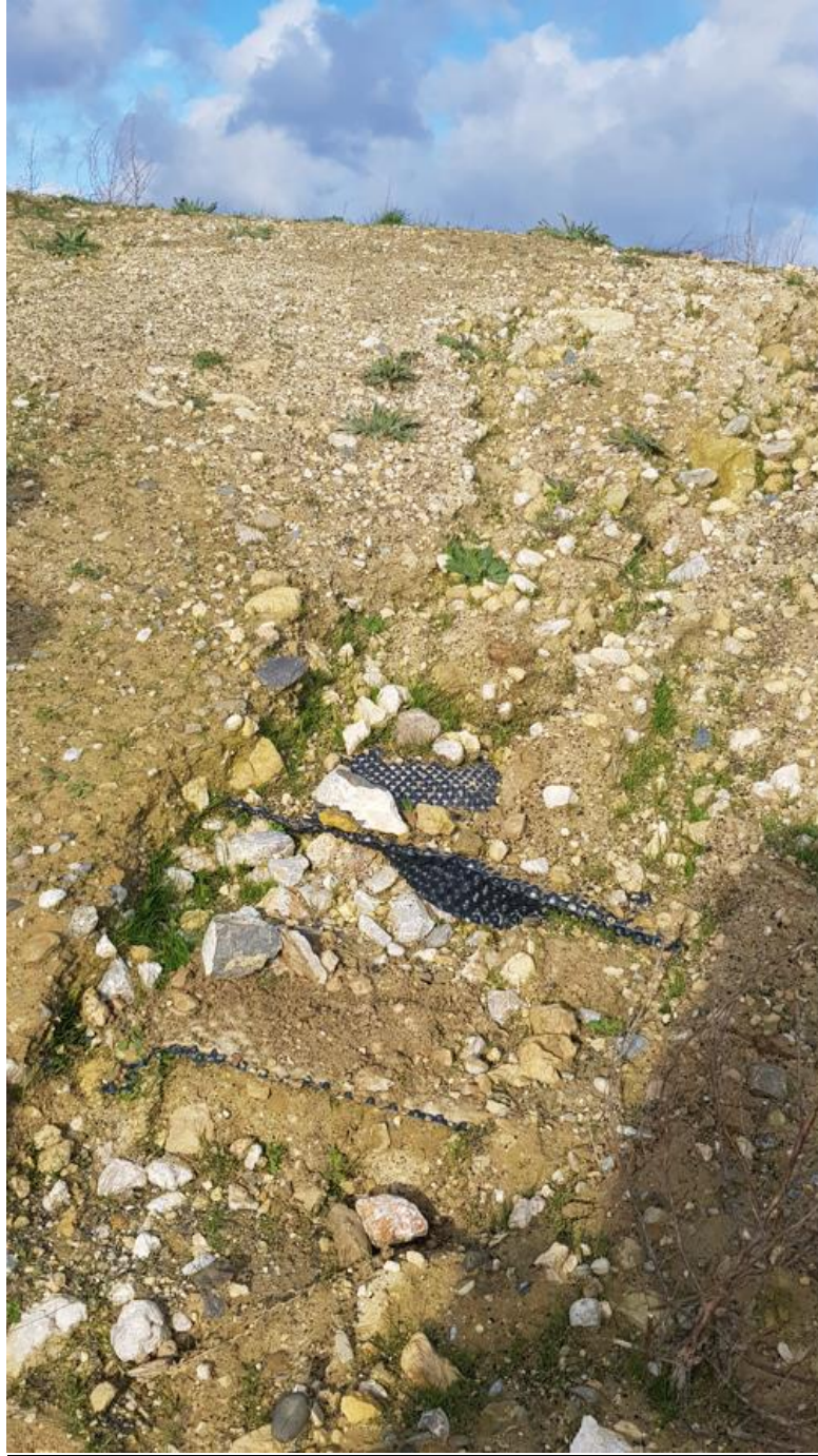
Zone 7 : Vue d'ensemble depuis le Nord-Ouest de la zone 7 avec mise à jour du DEDG
