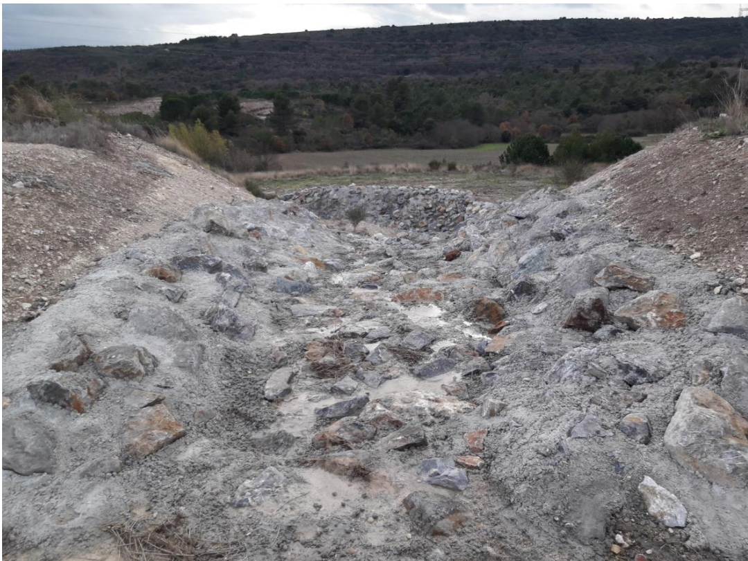
Point d'observation 8a : exutoires avec enrochements bétonnés
