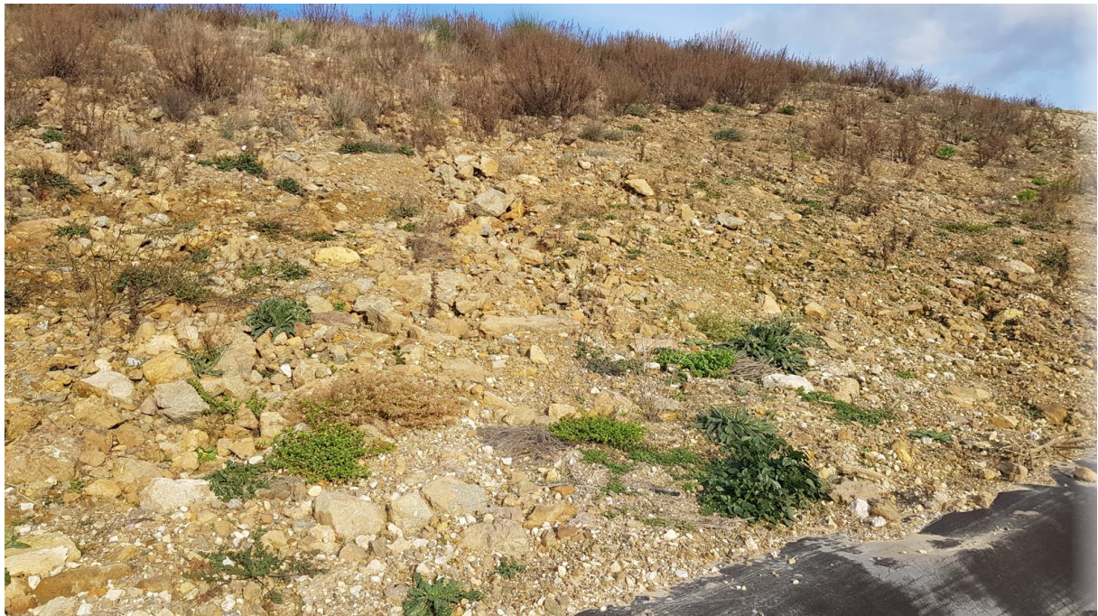
Zone 7 inférieure : Traces de ravinement sur le talus amont du fossé
