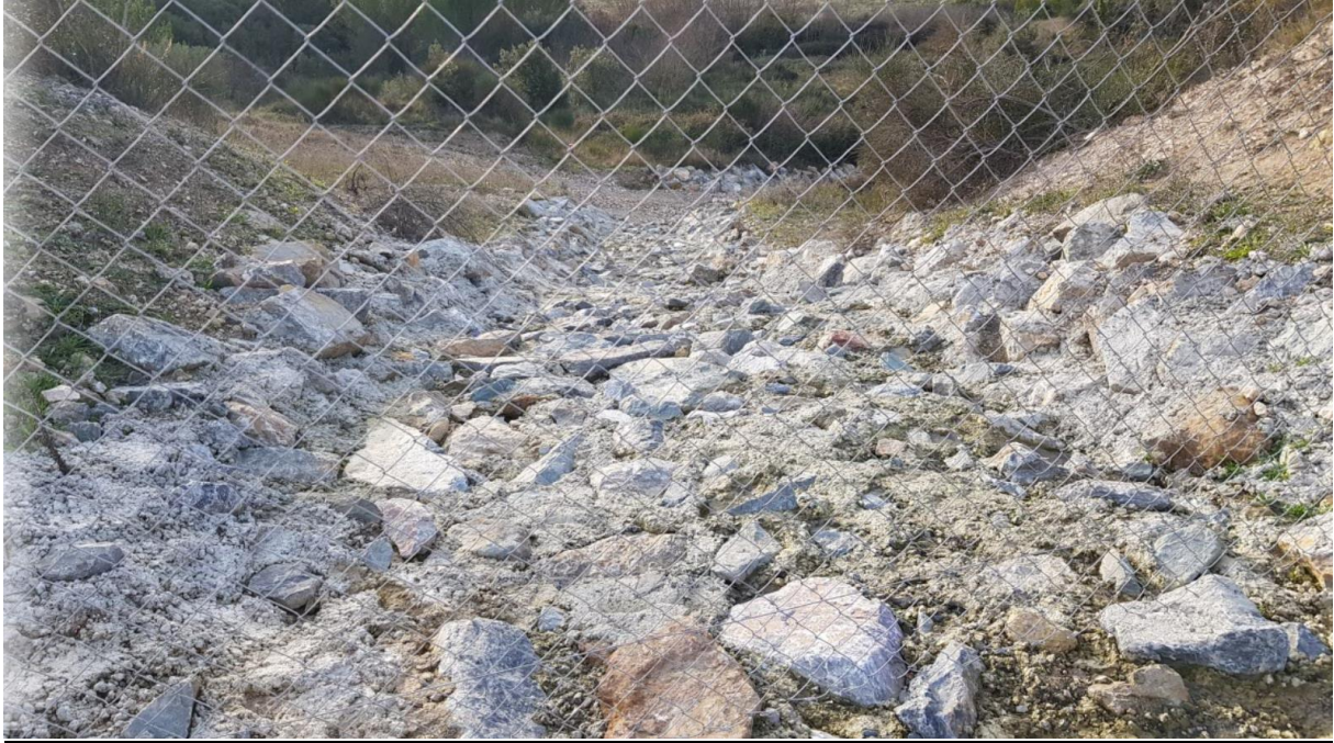
Point d'observation 8b : exutoires avec enrochements bétonnés
