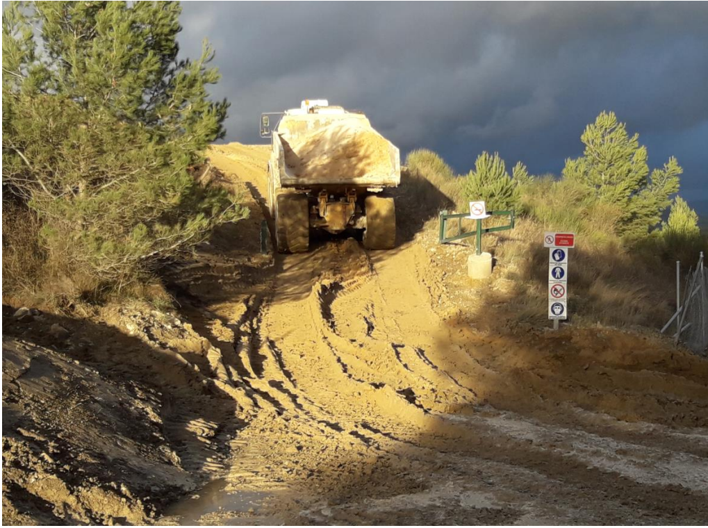
Point d'observation 1 en 2020: stockage provisoire de matériaux sur ancienne zone glissée et reprise
