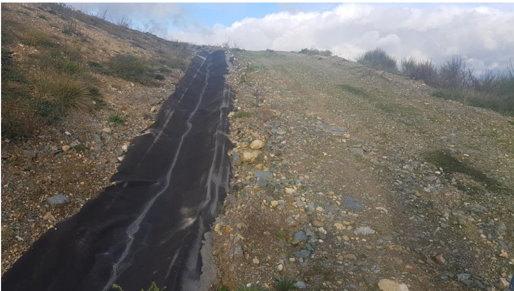
Point d'observation 1 en 2022 : reprise talus et fossé
